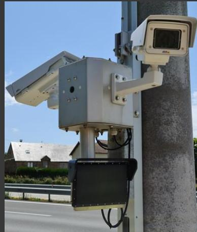
Lorsqu'un contresens est détecté, des clips vidéos synchrones de la détection sont envoyés à l'exploitant pour action.
