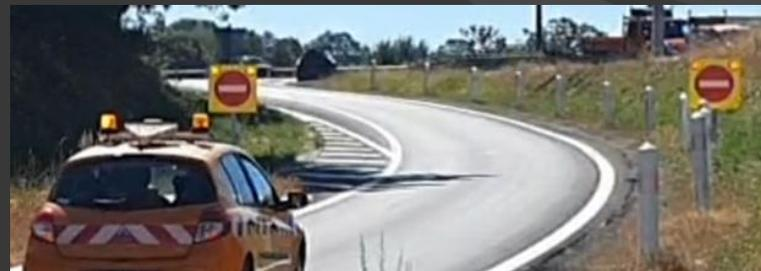
En section courante, dès réception d'une alerte par les opérateurs au centre de contrôle, les clips vidéo envoyés automatiquement leur permette de confirmer ou non le contresens. Le cas échéant, un scénario d'affichage sur les PMV en amont est enclenché, les autorités sont informées et des messages radios sont diffusées.
